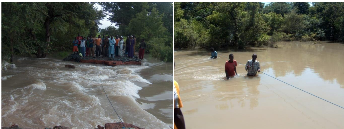
Photo 6 et 7 : Route coupée par inondations (Source : Ngadi Litadi., 2010)
