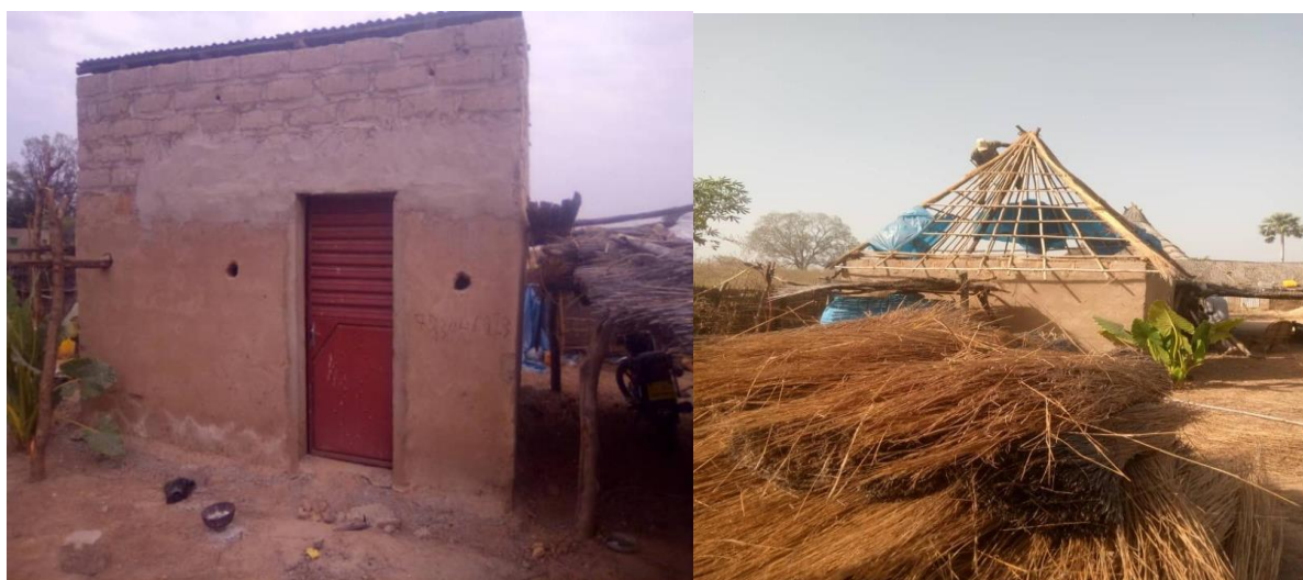
Photo 7: Réfection du Poste de Wassadou
